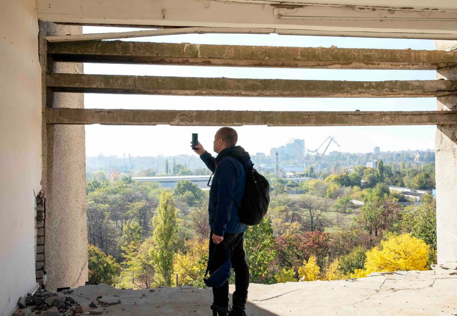
IUG'ere, der inspicerer en ødelagt bygning i Ukraine
