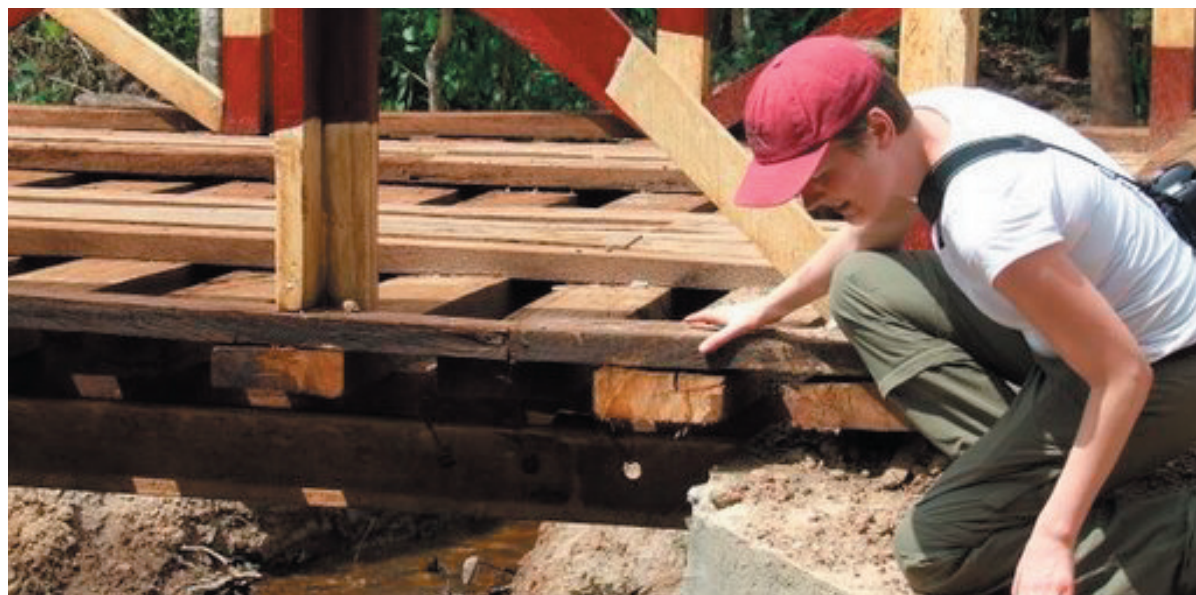
Susanne på broinspektion i forbindelse med sit arbejde i Liberia.
