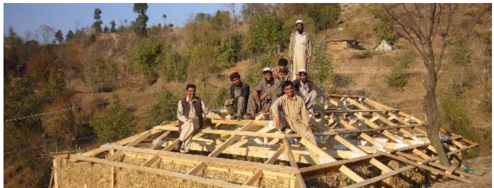
Foto: PAKSBAB. Konstruktion af et halmhus designet af PAKSBAB efter jordskælvet i 2006.
